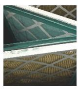
Våra CI-filter går även att få levererade i pappkassetter. Dessa filter är anpassade för att enkelt ställa i en ram och tar bort behovet av ett galler som håller filtret på plats. Vi har även använt dessa för att filtrera luften i lågtemperaturugnar och flash-offer.
